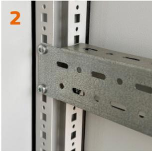
2 Усиление профиля дополнительными перемычками, скрепленными в двух плоскостях. Перфорированные перемычки позволяют размещать оборудование на необходимой глубине.
